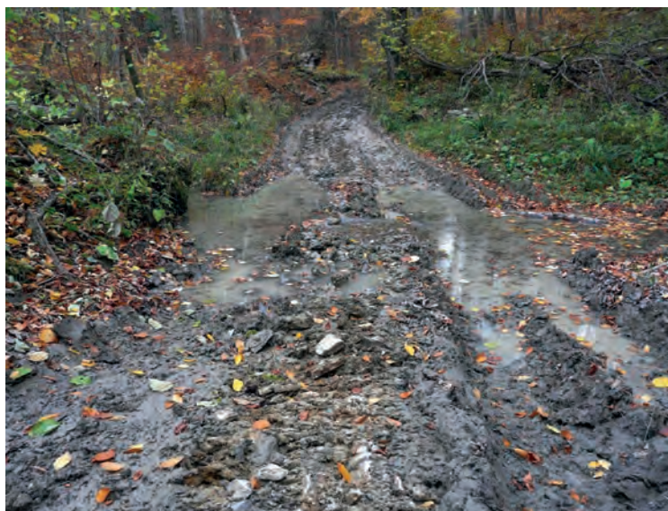
Fotografia 11. Nieumocniony przejazd w bród w ciągu drogi leśnej wykorzystywanej do zrywki (źródło: Algebar 2019)
