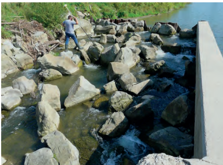
Fotografia 7. Bystrze kaskadowe ułożone wyłącznie z głazów zagłębionych w dnie do \frac{2}{3} ich wysokości – przepławka na rzece Wisłoka przy progu rafinerii w mieście Jasło (źródło: Algebar 2019)
