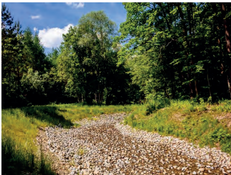
Fotografia 3. Bystrze o zwiększonej szorstkości w miejscu betonowego jazu, przywrócenie ciągłości biologicznej cieką przez Nadleśnictwo Krasieczyn (źródło: Archiwum CKPŚ)
