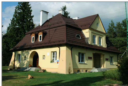
Ryc. 7. Kromków (d. DLP w Warszawie) – budynek leśnictwa zrealizowany około 1928 wg projektu K. Modlińskiego (ok. 1925). Stan w 2011. Fot. A. Novak-Zempliński.
