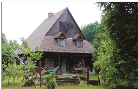
Ryc. 15. Wilków w Puszczy Kampinoskiej (d. DLP w Warszawie) – leśniczówka wzniesiona w Nadleśnictwie Kampinos według projektu wzorcowego Nr 1 (przed 1922). Stan w 2011. Fot. A. Novak-Zempliński.
