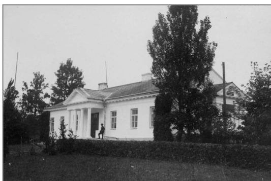
Ryc. 11. Białowieża, d. Leśnictwo Jagiellońskie k. Podolany (d. DLP w Białowieży) – budynek administracji (ok. 1921 [?]). Stan ok. 1938. Fot. ze zbiorów prywatnych
