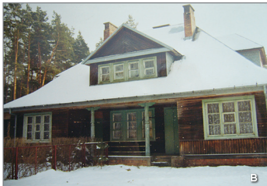
Ryc. 22. Leśniczówki dwumieszkaniowe. A – leśniczówka w Zwierzyńcu (d. DLP w Warszawie) zbudowana ok. 1920. Stan w 2012; B – leśniczówka Rupin w Budziskach (d. DLP w Siedlcach) zbudowana ok. 1938. Stan ok. 2002. A – fot. ze zbior. OKL w Gołuchowie; B – A. Frąc, KEZAiB, 2002
