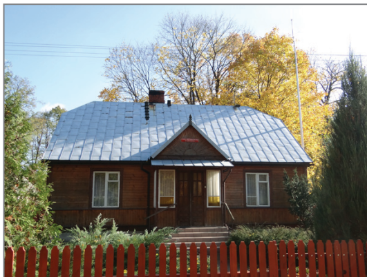
Ryc. 13. Osada Dąbrówka (d. DLP w Warszawie) – leśniczówka (ok. 1920) w obecnym Nadleśnictwie Łuków. Stan w 2012. Fot. ze zbior. OKL w Gołuchowie.
