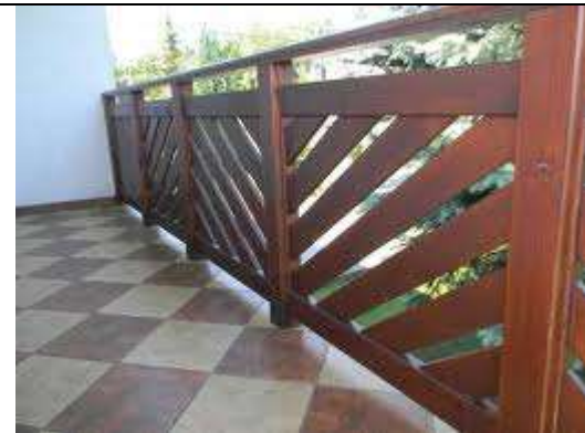
Balustrada zewnętrzna z drewna (3)
