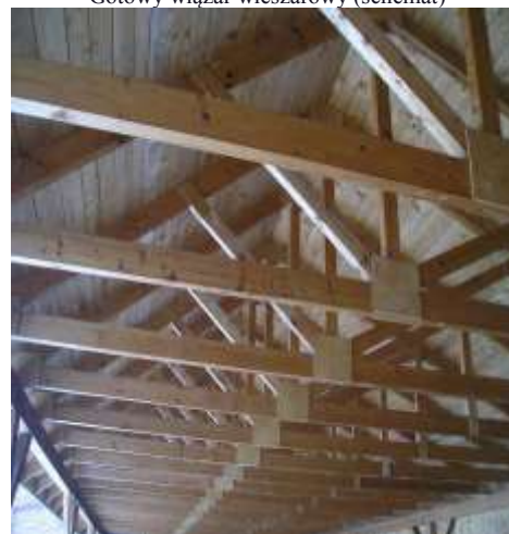
Więzba dachowa z gotowych więzarów
