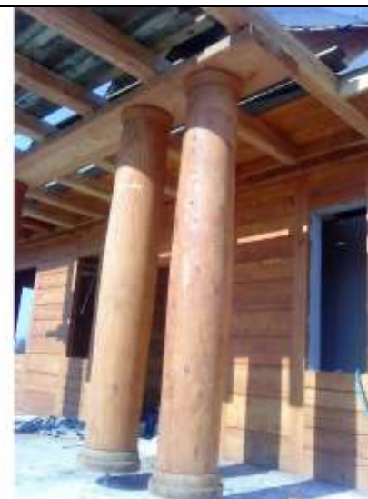
Kolumny drewniane w zastosowaniu zewnętrznym
